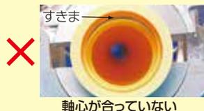
●フローティング・レバーを操作して管側クランプ位置を調整し、管と継手の隙間が無くなるよう、**軸芯を合わせ**ます。
