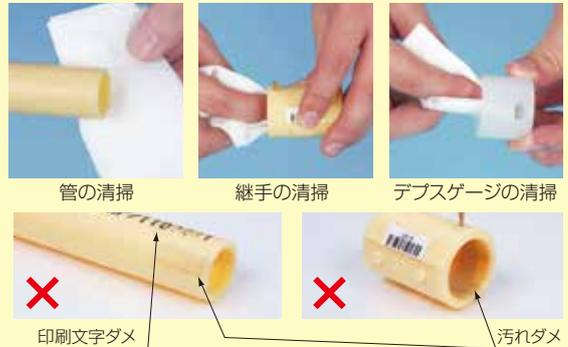
●パイプの外表面(スクレーパーで削ったところ)と、継手の内表面、デブスゲージをそれぞれアセトンをしみこませた清潔な紙ウエス又はガーゼできれいに清掃して下さい。
